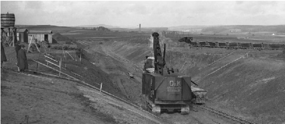
Bau der RAB auf der Höhe von Großmuß. Das Foto von 1939 zeigt, dass neben einer Feldbahn auch ein Bagger für die Trassierung eingesetzt wurde. Im Hintergrund, etwa in der Bildmitte, erkennt man den Ziegeleierturm von Großmuß.
