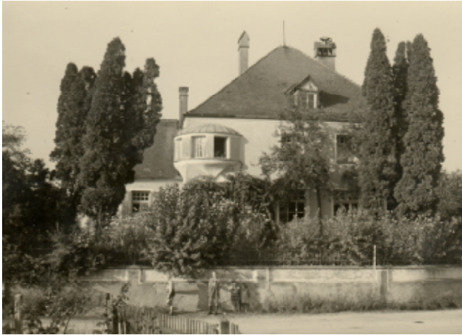
Die Schule in Hausen in den 1950er-Jahren. Im oberen Stockwerk war die Dienstwohnung des Lehrers mit Familie untergebracht. Eine Reihe von Umbaumaßnahmen und Erweiterungen erfolgten über die Jahrzehnte. Im linken Anbau war die Gemeindekanzlei untergebracht.
