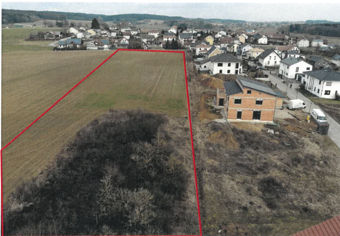
Abbildung 2 Bestand, Blickrichtung von Westen nach Osten
